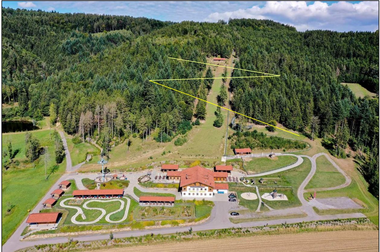
Ungefäherer Verlauf Flying-Fox am Urberberg. Bauliche Einrichtungen und Stahlseil sind durch den Baumbestand nahezu vollständig abgeschirmt.
