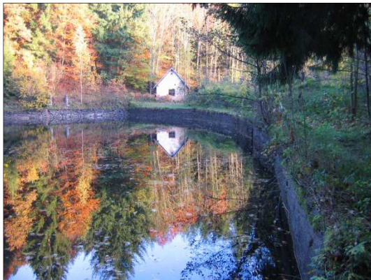
Abb. 12: Bestand des Stauweihers mit südseitiger Beton-Staumauer, Aufnahme MKS Architekten – Ingenieure GmbH vom 31.10.2012
