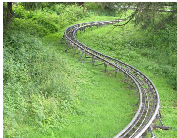
Abb. 17: Coaster-Streckenverlauf mit Erdnägeln zur Fundamentierung, Quelle: Alpinforum.com
