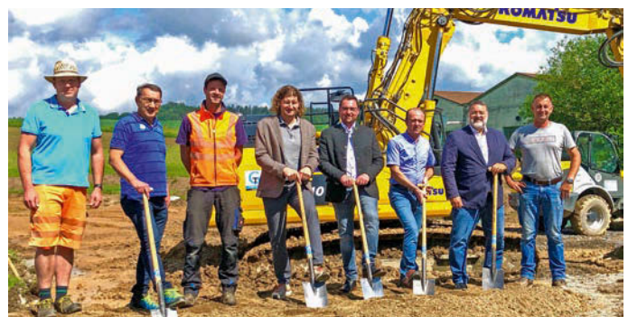
Bürgermeister Max Höcherl (4. von rechts) freut sich beim Spatenstich gemeinsam mit Peter Baier vom Ingenieurbüro Sehlhoff (4. von links) und Uwe Gegenfurtner von der Gegenfurtner Tiefbau GmbH (3. von rechts) über die Entstehung neuer Bauparzellen in Ehren.
