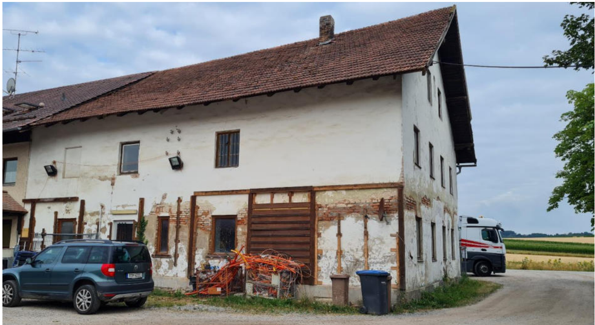
Abzubrechender Teil des Wohnhauses
