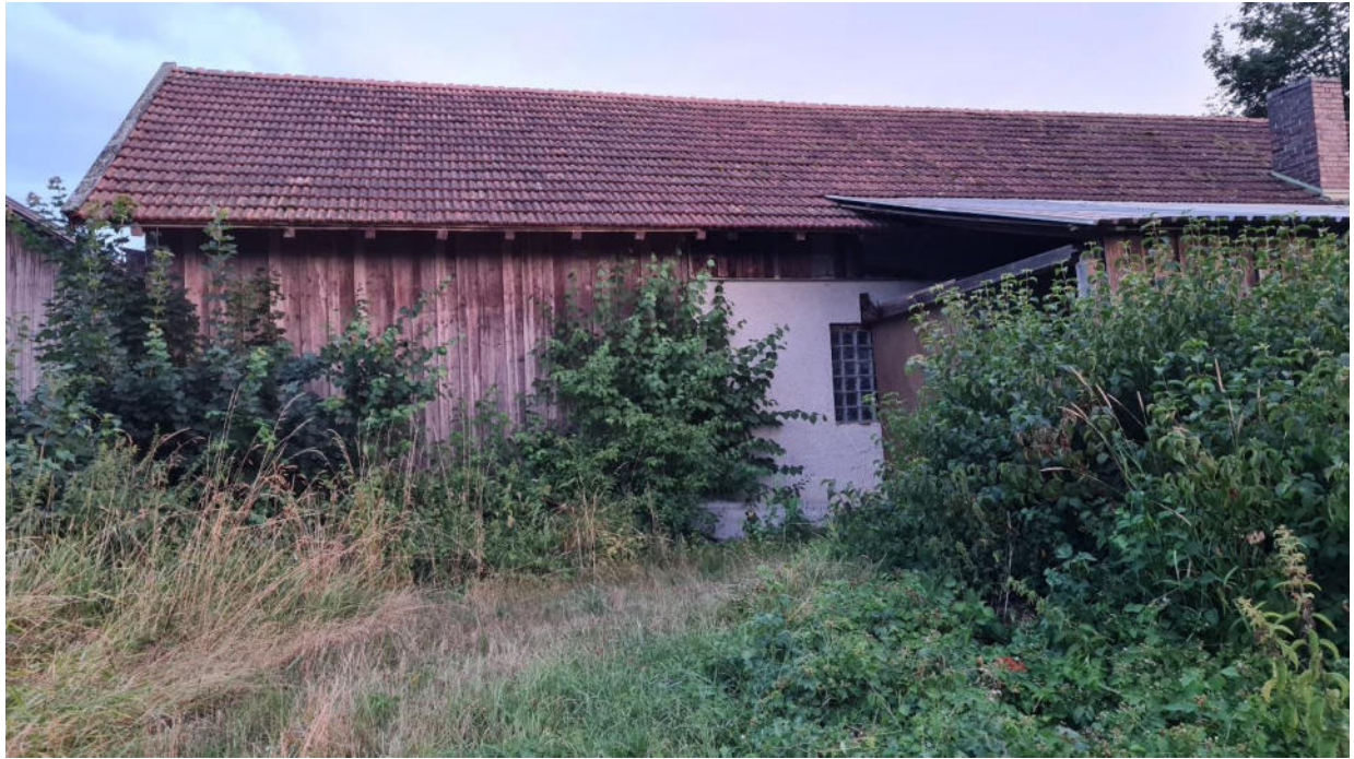
Scheune von Norden
